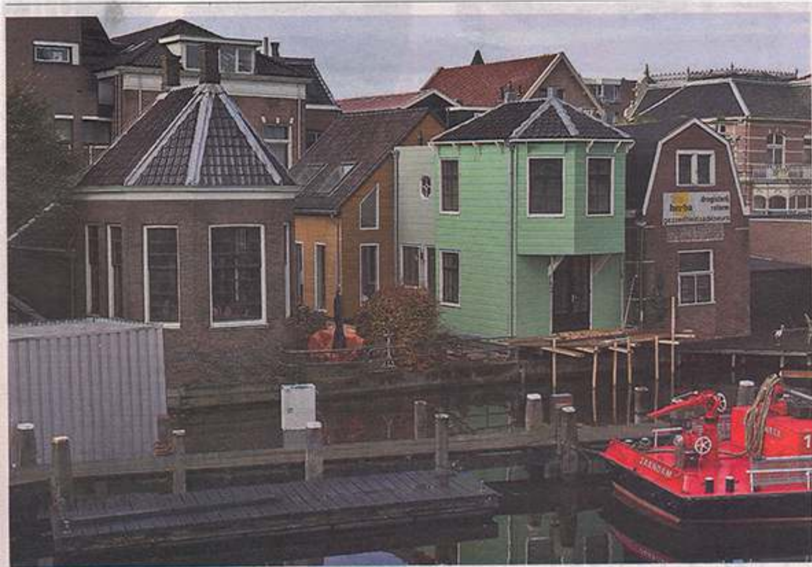
Het hoekje met theehuis (links) en in Monetgroen geschilderde luchthuis moet bereikbaar worden vanaf de brug.
